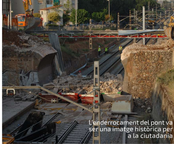
L'enderrocament del pont de la via donava inici a la ruta alternativa
