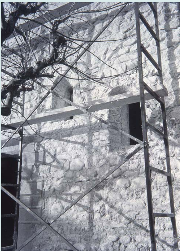
Obres de restauració. Van quedar al descobert finestres romàniques que estaven tapades. Fotografia: SPAL. Diputació de Barcelona. 1967.
