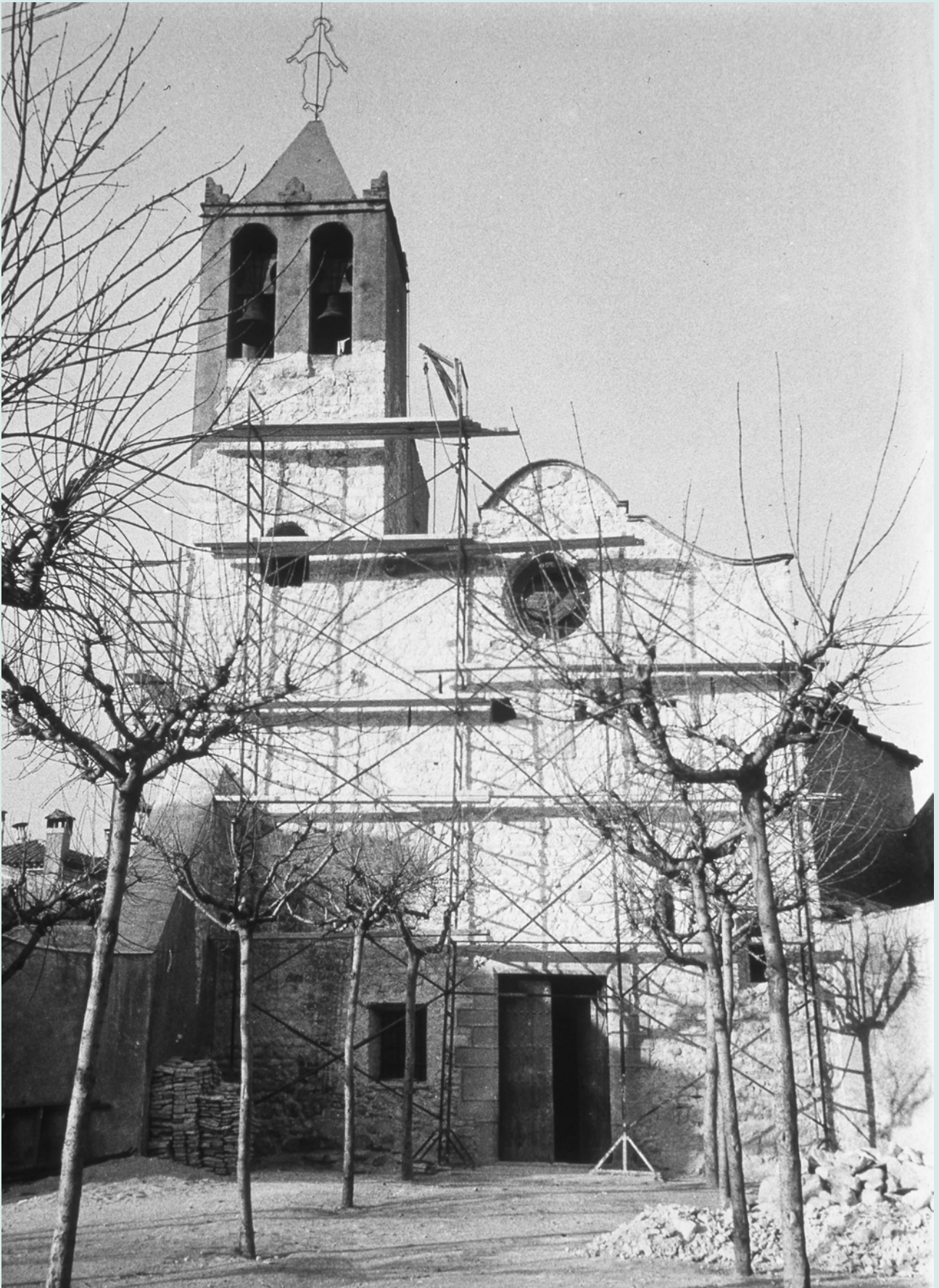
Obres de restauració. Fotografia: SPAL. Diputació de Barcelona. 1967.
