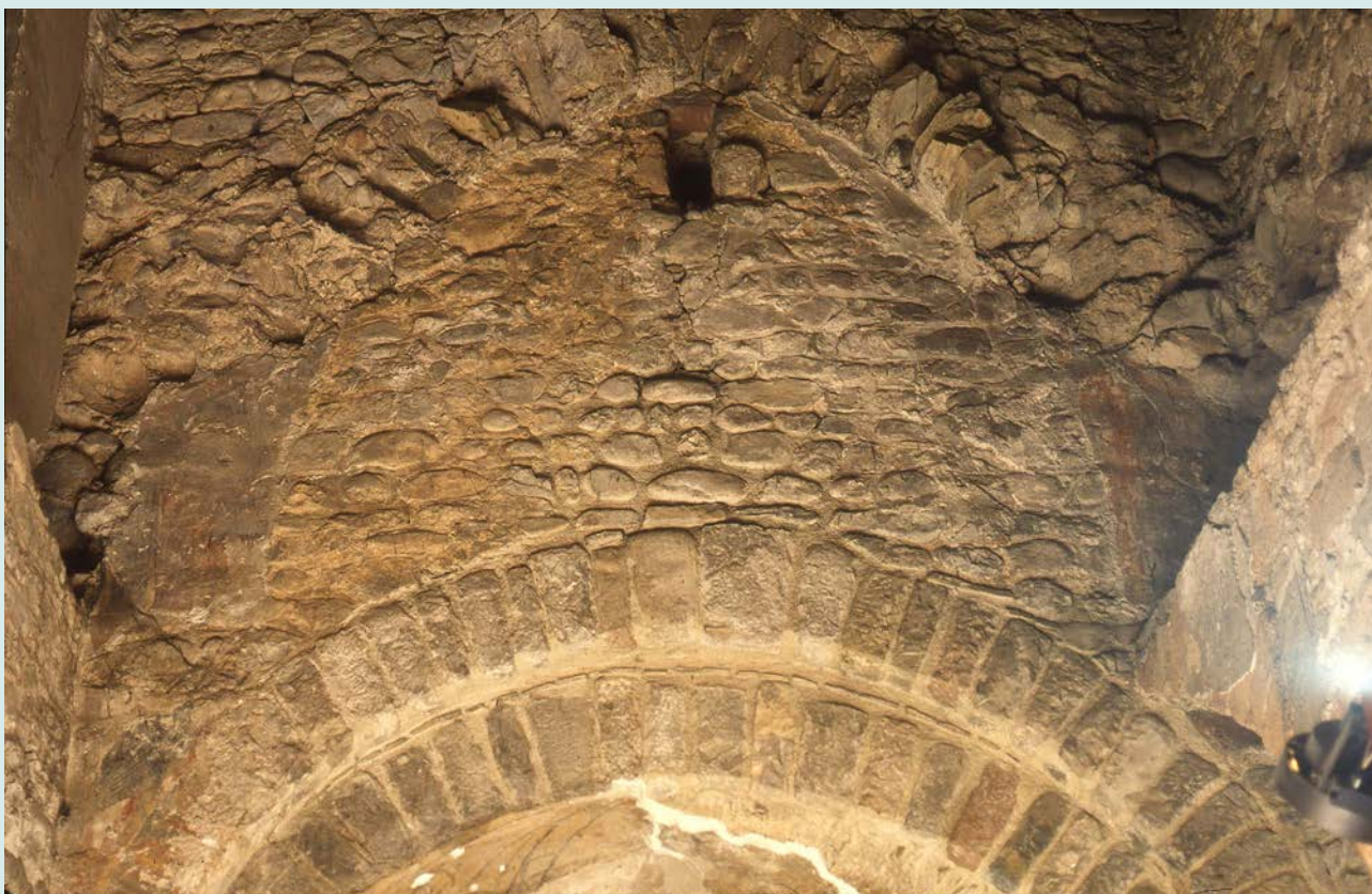
Restes de la volta apuntada a la part superior de l'absis. Fotografia: Josep Umbert
