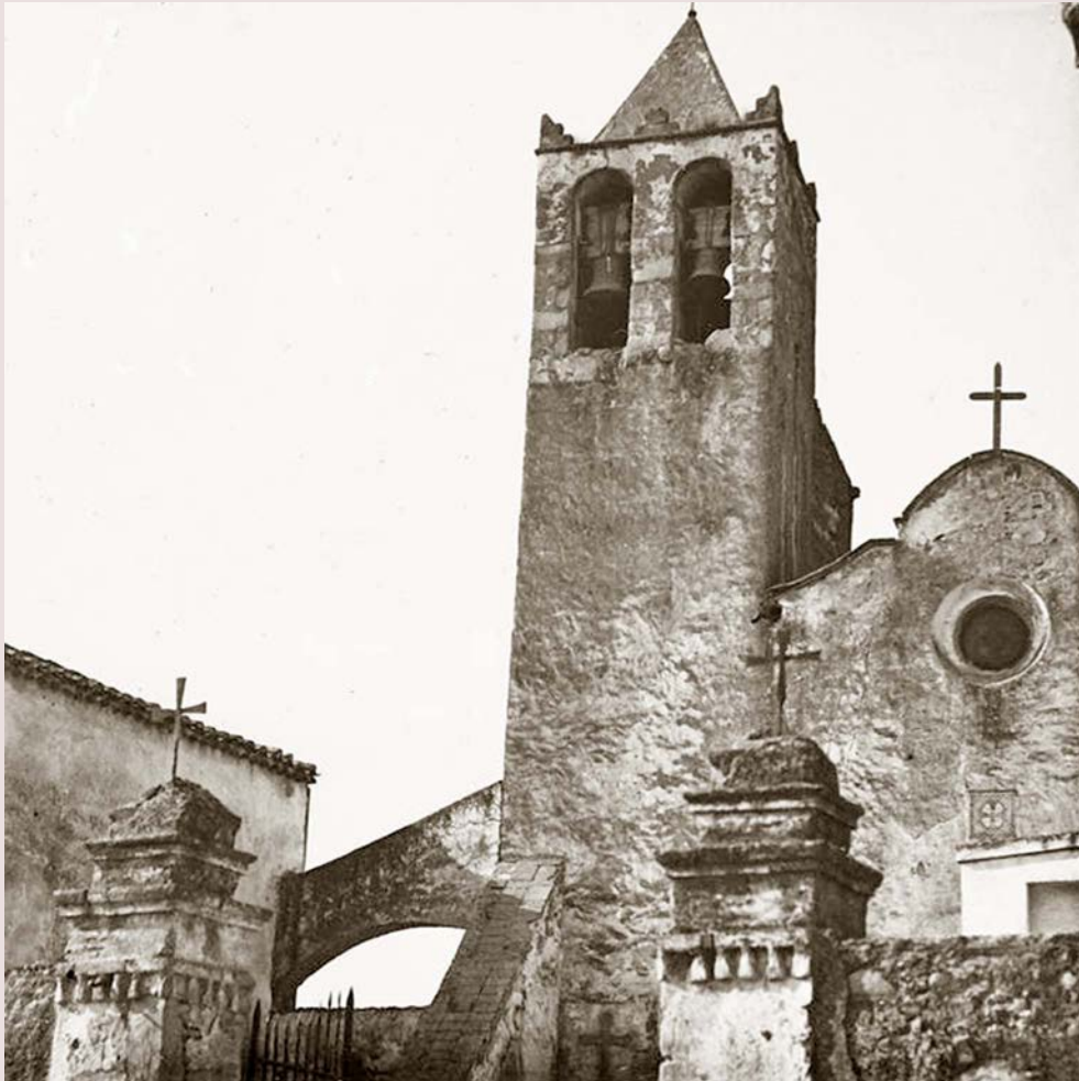
Vista del campanar l'any 1912. S'hi aprecia el contrafort entre la rectoria i el campanar per tal de reforçar el recolzament del campanar, que ja es deuria trobar en males condicions. Fotografia: Josep Salvany. Fons Salvany. Biblioteca de Catalunya
