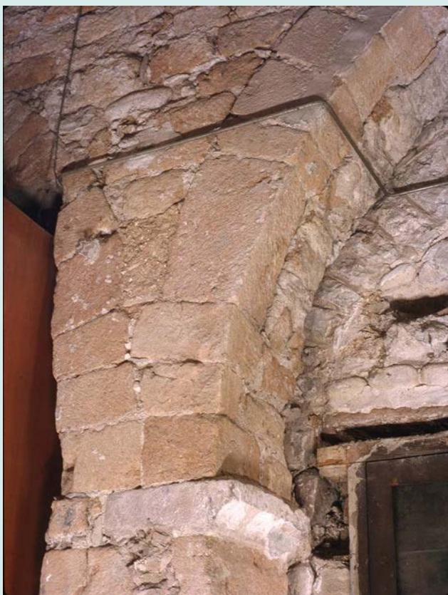
Detall de l'arcuació que s'adossava a l'interior del mur per poder aguantar el pes de la nova volta. Fotografia: Josep Umbert
