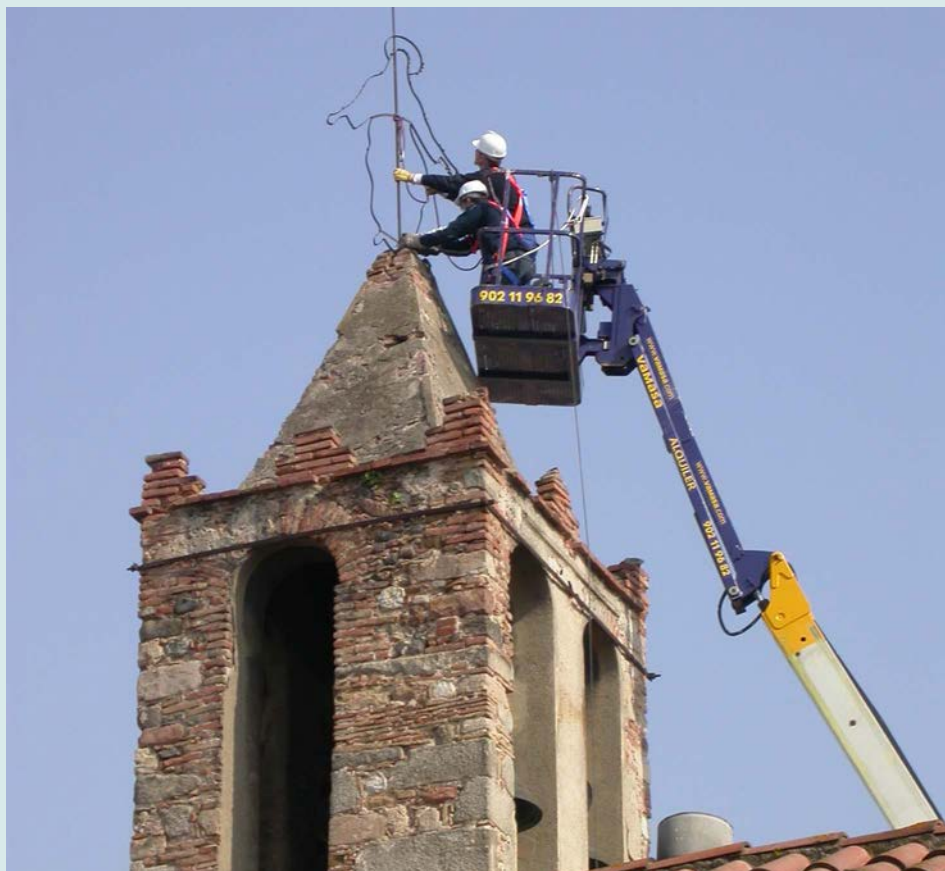
Procés de restauració del campanar. Fotografia: SPAL. Diputació de Barcelona. 2004
