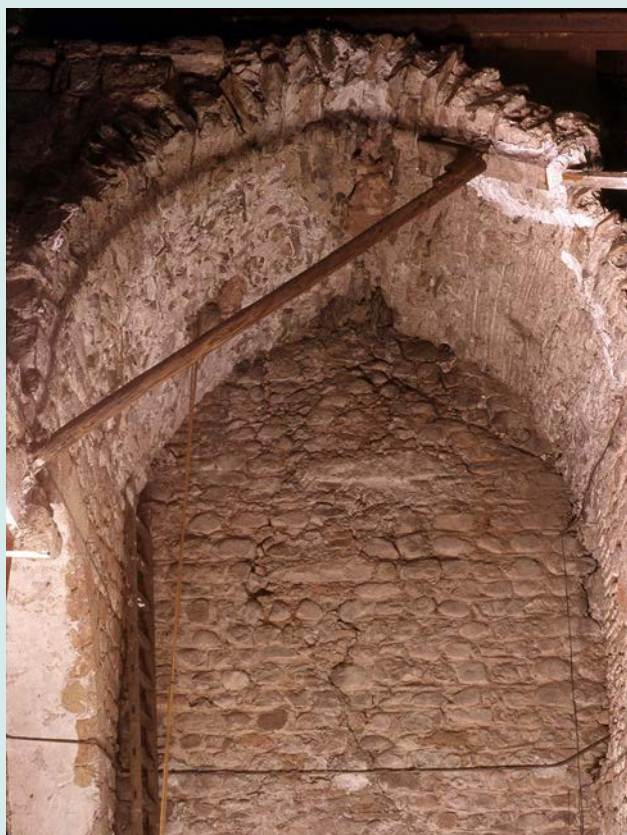
Fragment de la volta de canó apuntat sota el campanar i restes de la coberta anterior, a dues vessants. Fotografia: Josep Umbert
