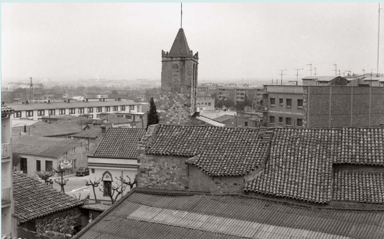
Vista de la teulada de l'església i els edificis annexos que impeden veure l'absis. Fotografia: Josep Umbert. 1986
