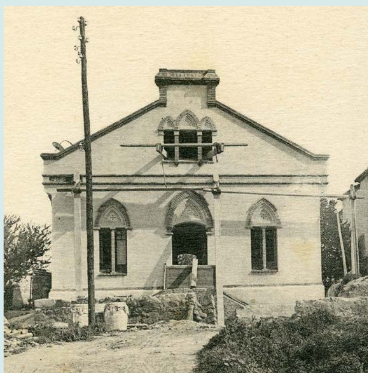
Imatge de la construcció de la nova rectoria. 1927 Fotografia: Lucien Roisin
