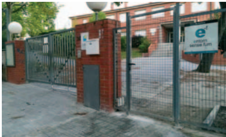
Instalación de una segunda puerta de acceso en la escuela Pau Casals
